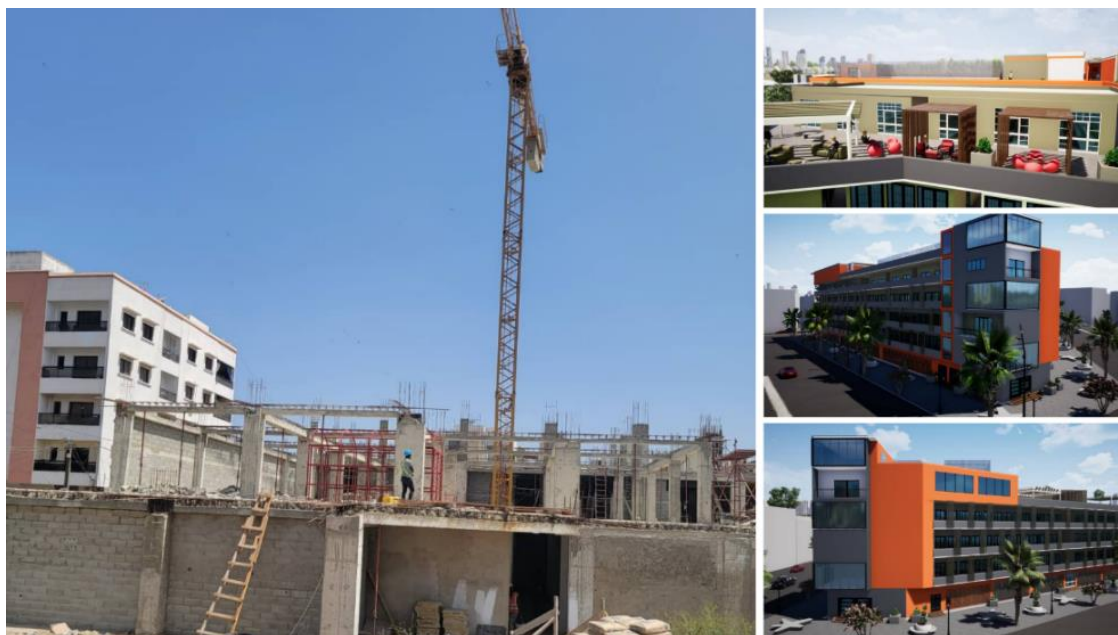
Photo 52 : Projet de construction de cantines à Gueule Tapée dans le département de Dakar. Source : KSB, 2024
