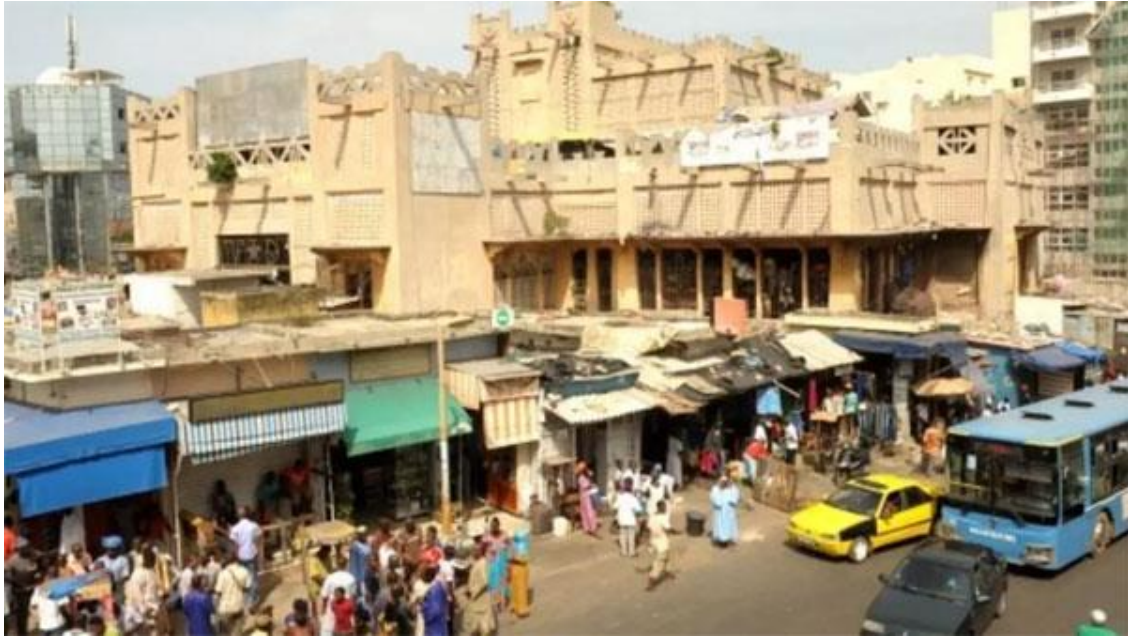
Photo 51 : La vétusté et l'encombrement autour du marché Sandaga de Dakar, 2012. Source : https://lequotidien.sn/
