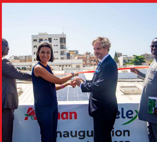
Installations de panneaux solaires en magasins
