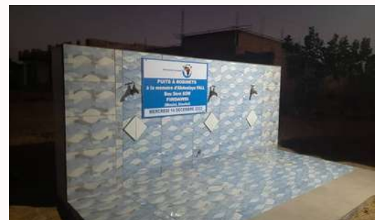
Puit à robinets installé à Mbacké , Diourbel
