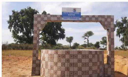
Puit traditionnel installé à Ndiefer Kaymack , Fatick
